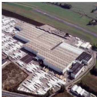
Oyonnax Arpent Site d'injection
