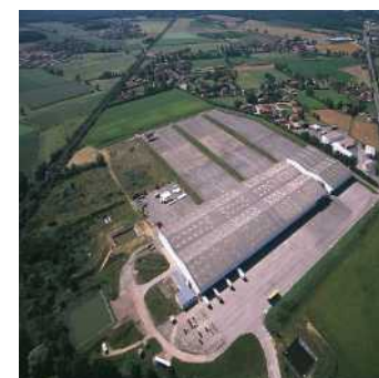
Certines Site d'assemblage
